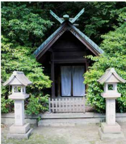
遥拝所とは、読みの通り 遥(はるか)に拝(おろが)む所です。 建物の向側に白布が掛かっておりますが、その向こうに神社等がいらっしゃると思ひ浮かべて拝みます。 檜材銅板葺の神明造 大正15年3月竣工
