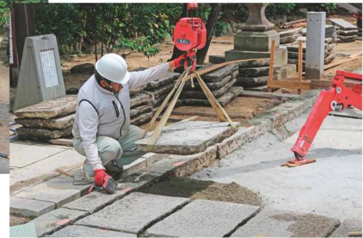
石畳工事の様子
